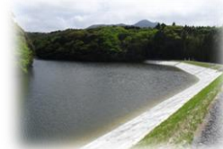
<ため池の改修>
